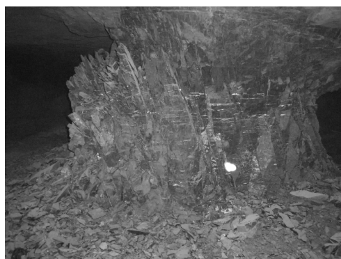
图 1 磷块岩矿柱沿节理受压剪切破坏
