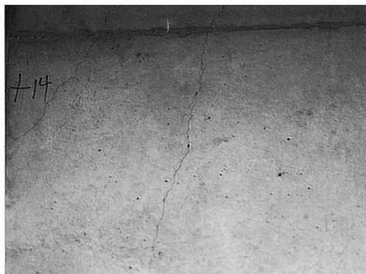
(b) 去模糊后的桥梁病害图像
